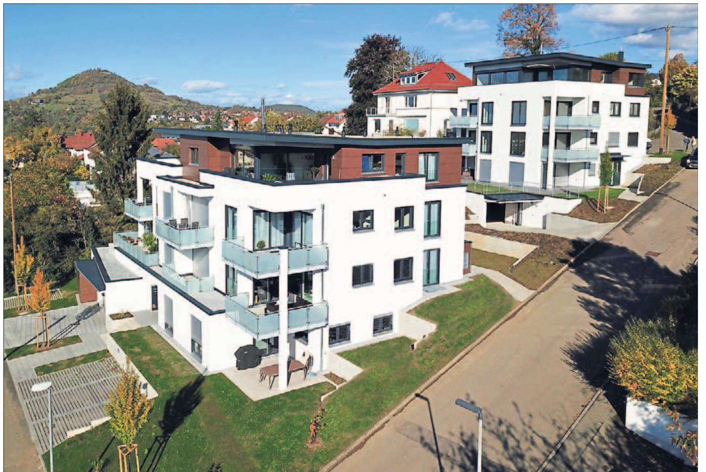
Mit Aussicht: In Pfullinger Höhenlage sind 15 großzügige Wohnungen mit Freisitzen entstanden.
